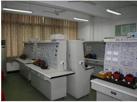
电力电子及电气传动实验室
